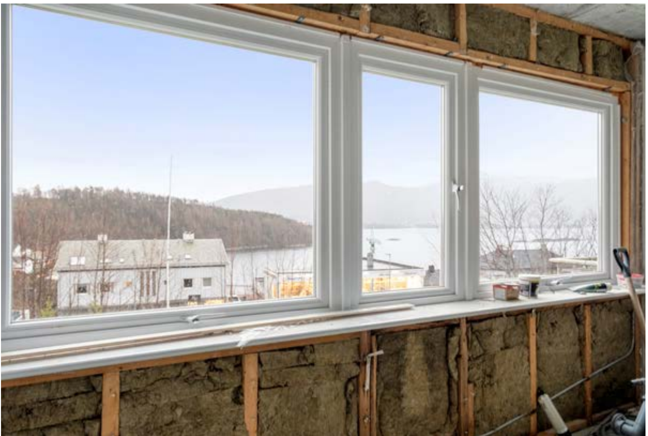
Vinduene er byttet til moderne 3-lags vinduer
