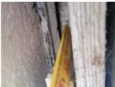
Synlig brannfarlig isolasjon i værvegg.
