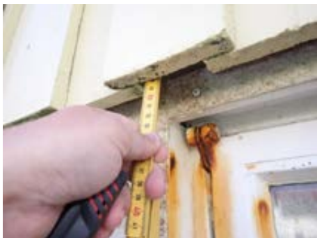
Synlig brannfarlig isolasjon i værvegg.
