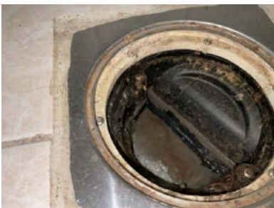
Plastsluk uten tettesjikt underklemring.
