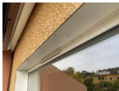
Manglende lufting/vannbrett over dører/vindu.
