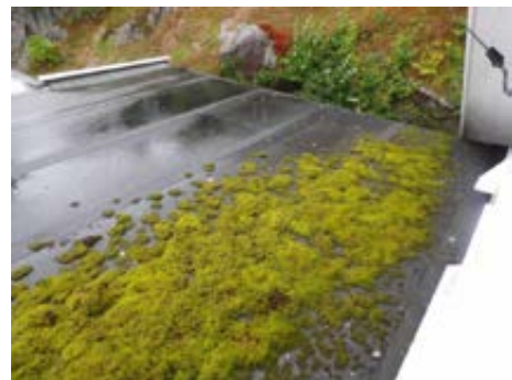
Mose på tak over vinterhave.
