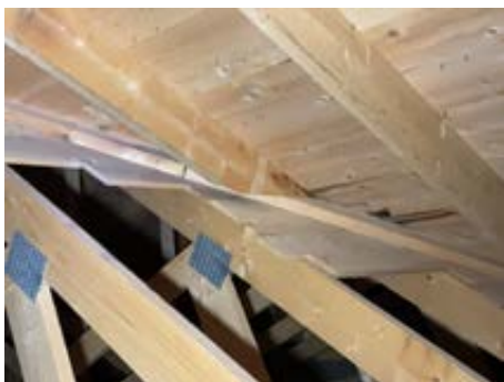
Fuktmerker på trod i gradrenne.
