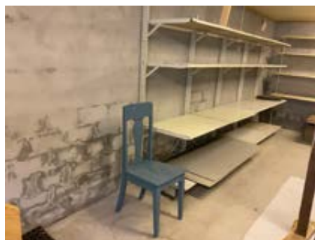
Spor av fuktighet på mur/gulv i kjeller.
