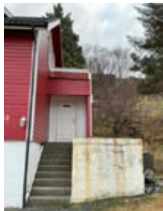
Det mangler rekkverk på betongplate utenfor hovedinngang.
