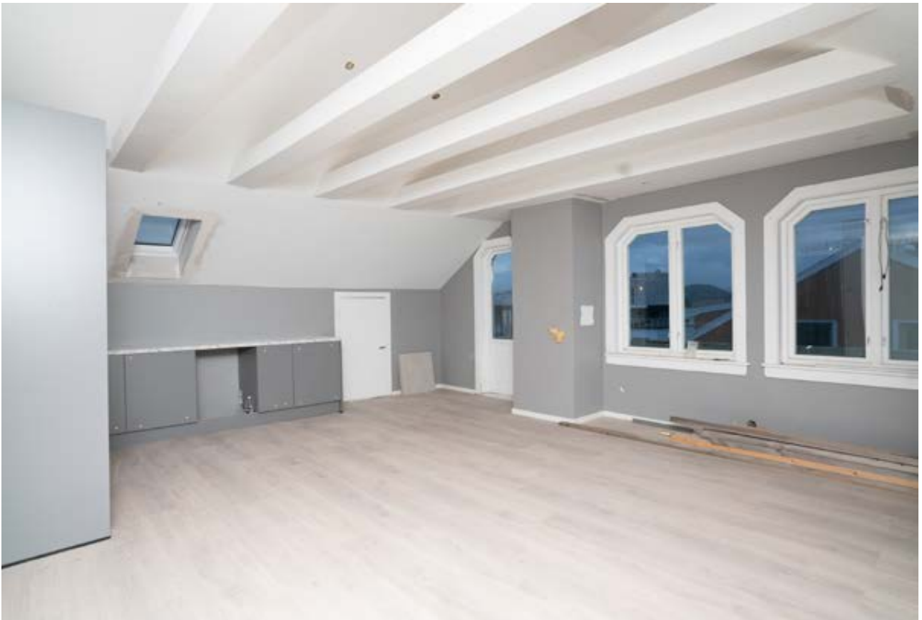
Påbegynt leilighet 4. etasje
