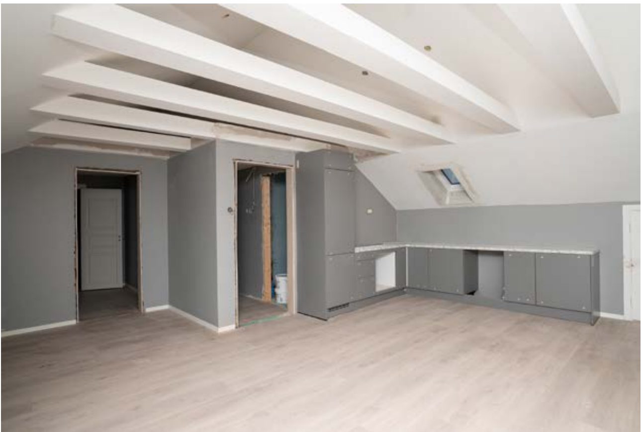
Påbegynt leilighet 4. etasje
