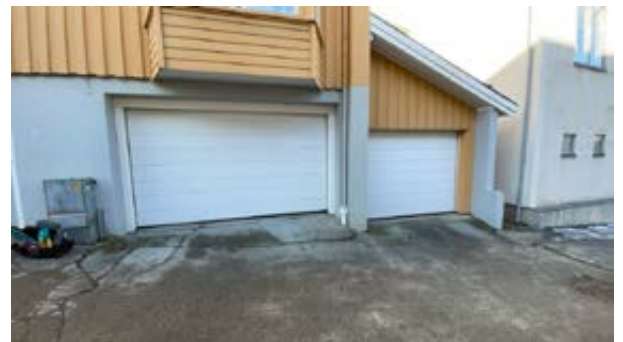
Garasjeport (til høyre)
