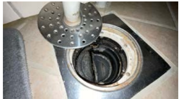
Plastsluk under innredning.
