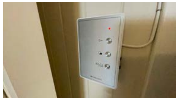
Dørklokke med åpningsmulighet av ytterdør.
