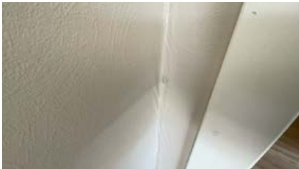
Stedvis dradd tapet i hjørner
