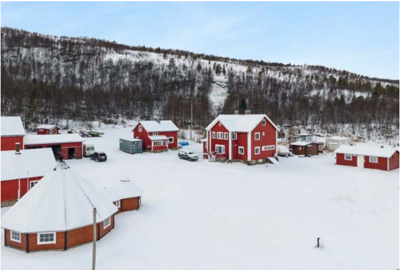
Dronebilde over deler av bygningsmassen
