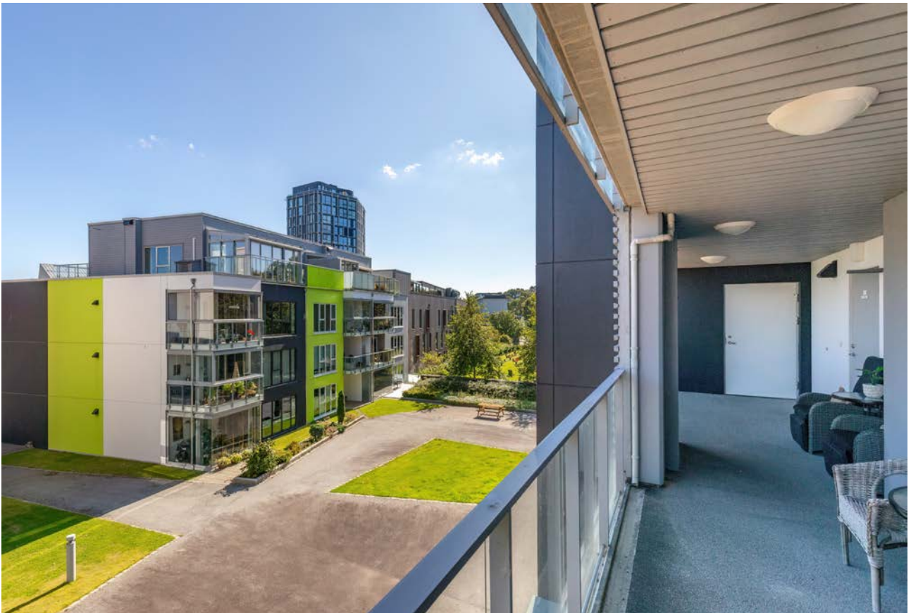
Inngangsparti via svalgang
