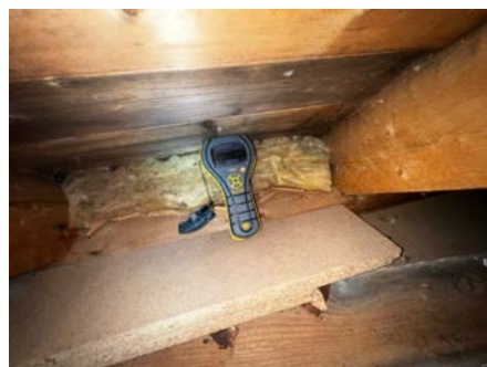
Sperreroom er fullisolert stedvis. Ikke målt forhøyet fuktverdier på befaringen.
