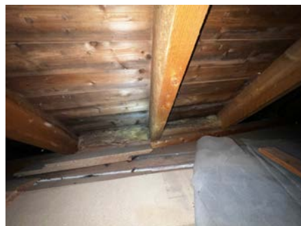
Sperreroom er fullisolert stedvis.
