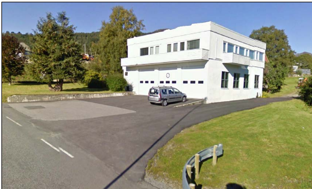
Tidligere brannstasjon i kombinasjon med boligareal. Brannstasjonen hadde tilhold i 1. etasje, 2 boenheter i 2. etasje.
