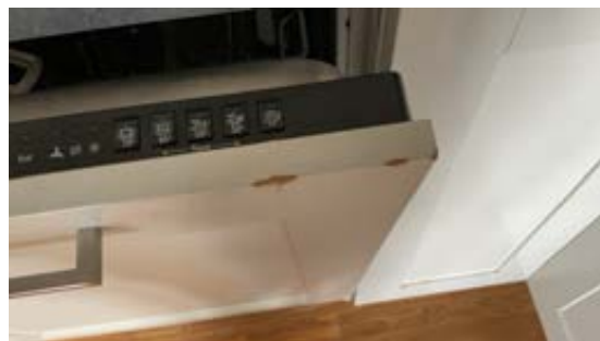
Svelling på frontdør oppvaskmaskin.
