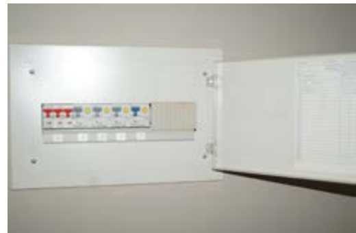
Skap i underetasje
