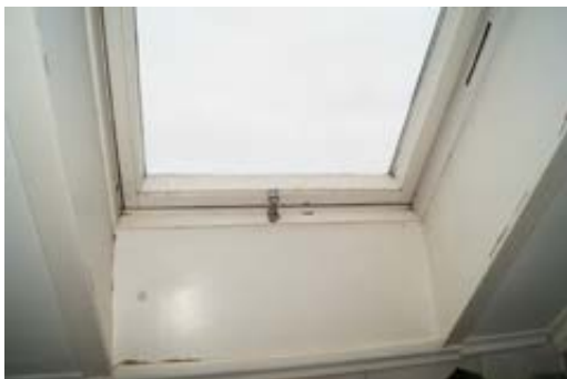
Et takvindu på bad
