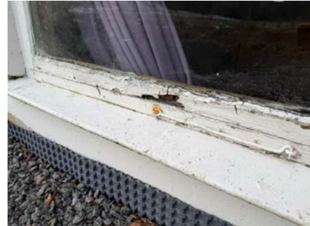
Råteskadet kjellervindu.
