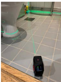
Kontroll med krysslaser av høydeforhold
