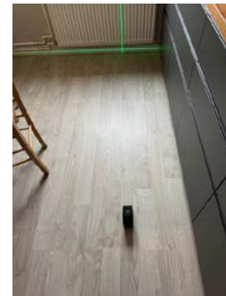
Foto viser nivellering med krysslaser på kjøkkenet
