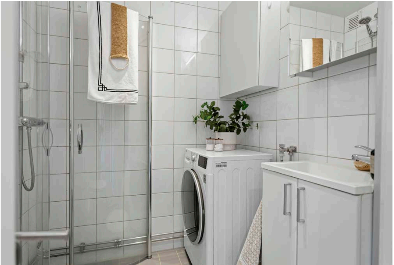
Flislagt bad med varmekabler i gulv og senket, malt platehimling med downlights. Badet er utstyrt med et gulvmontert toalett, servant med underskap, speilskap over servant og et veggskap.
