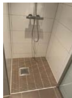
Dusjhjørne med nedsenket gulv.
