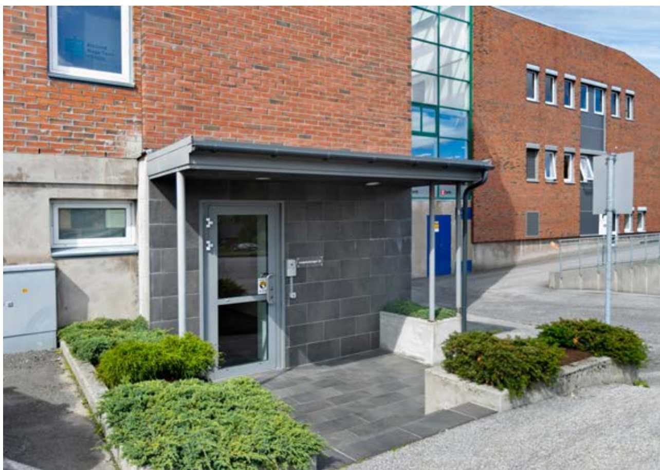
Innkjørsel til garasjeanlegg samt igangspartiet til leiligheten ligger på sørsiden av bygget
