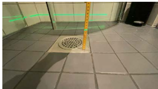
Høydeforskjell (ved sluk)
