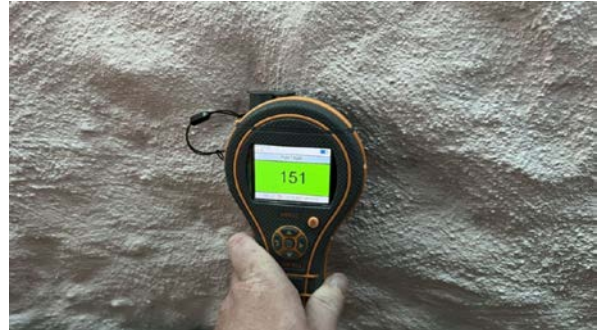
Ikke utslag på fukt på vegg mot vegen i kjelleren
