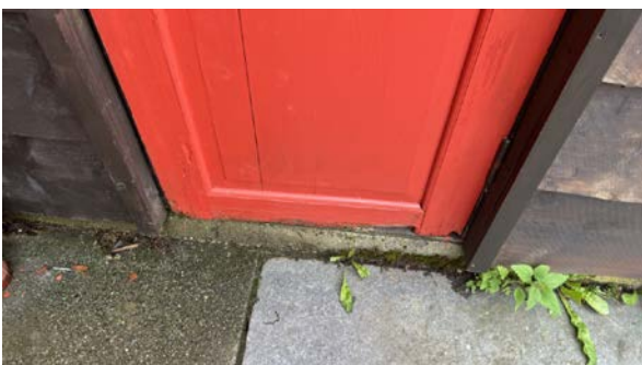
Råteskadet dør
