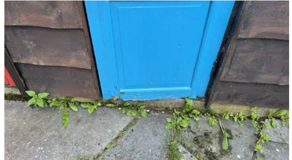
Råteskadet dør
