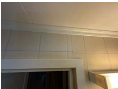
Ufagmessig montering av våtromsplater på vegg.
