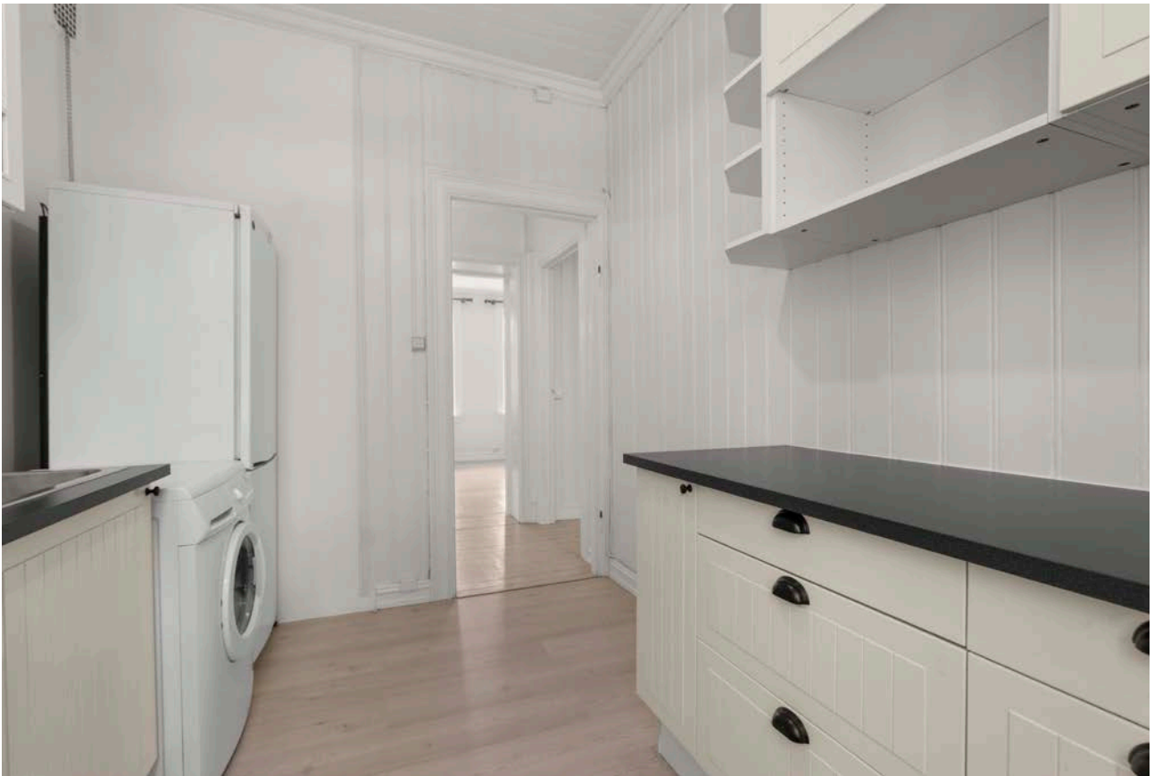
Opplegg vaskemaskin. Laminat på gulv.
