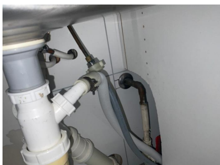
Lekker ifra rør fra servant.
