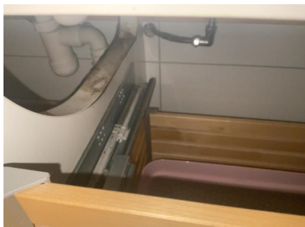
Lekker ifra rør fra servant.
