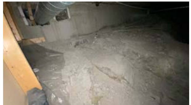
Ingen synlig fukt.
