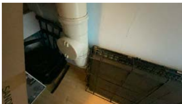
Stakeluke i kjellerbod.
