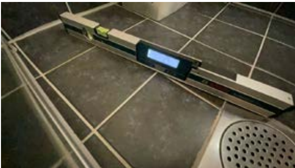
25 mm/meter fall mot sluk i dusjnise.
