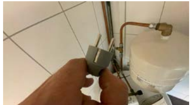
Ingen synlige svimerker på stikk ved dagens befaring.
