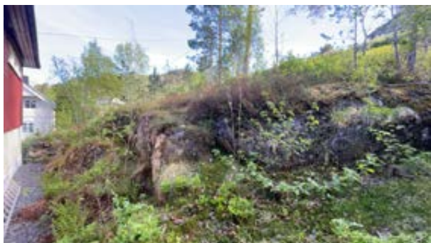
Mot øst er det fall ned mot kjelleretasje
