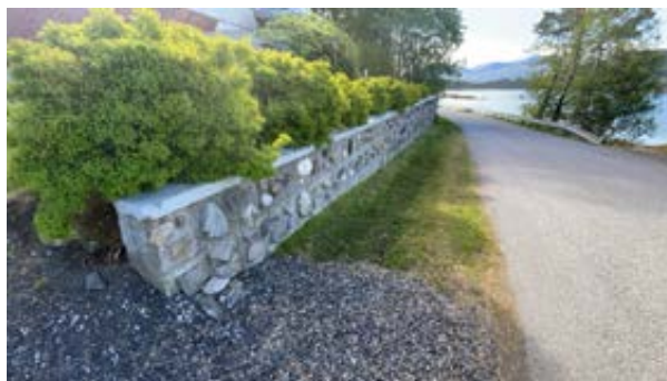
Forstøtningsmur mot offentlig vei
