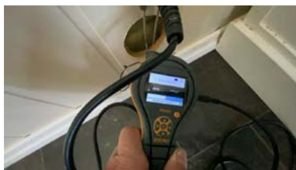
Piggmåling under 7 vekt% ved dagens befaring.
