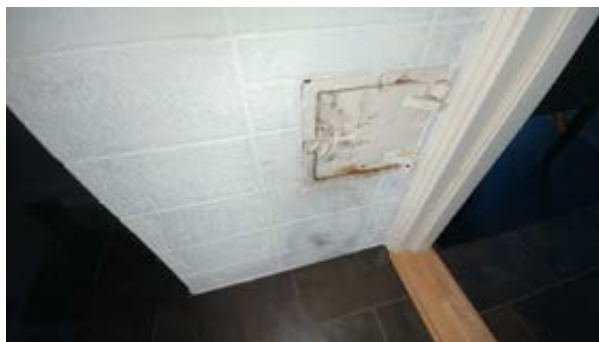
Sotluke i hall med trapp.
