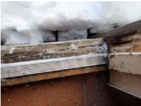
Råteskadet karm
