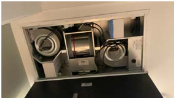
Ensy ventilasjonsaggregat.
