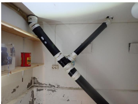
Plast avløp fra bad og kjøkken
