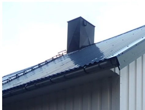
Heldekkende pipebeslag
