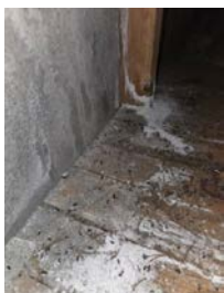
Bildet viser spor etter mus og saltutslag ved pipe på hems
