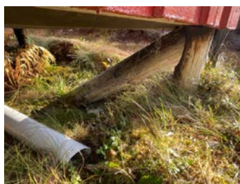
Det er satt opp støtter på hjørner ved byggeår
