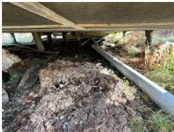
Oversikt krypkjeller sett fra utsiden
