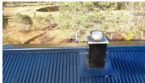
Heldekkende pipebeslag
