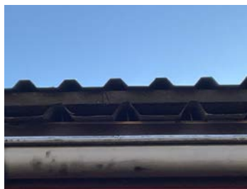
På taksiden mot nord er det synlig at det nye taket er montert over den eldre taktekingen
