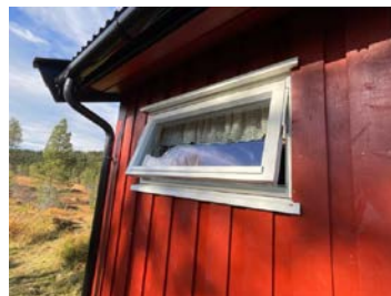
Oversikt vindu på bod
