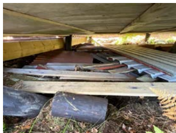
Oversikt krypkjeller sett fra utsiden
