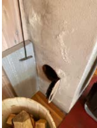
Sotluke og brannmursplate mot vegg
