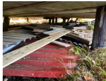
Oversikt krypkjeller sett fra utsiden
