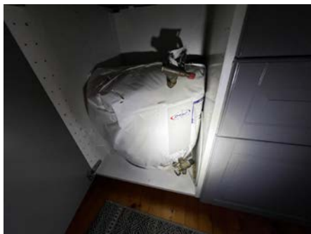
Varmtvannstank.
