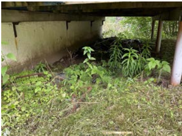
Areal under terrassen.
