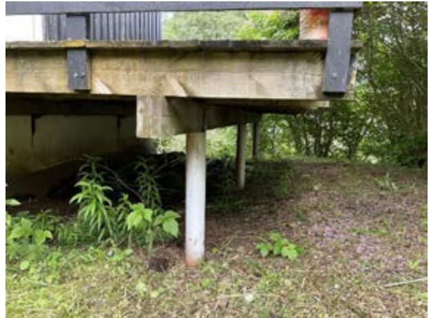
Underkonstruksjonen av terrassen.
