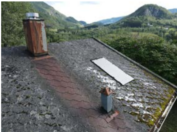
Skorsteinbeslag, luftehatten og et reparert område på taket.
