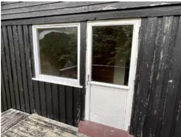
Terrassedøren og vinduet.
