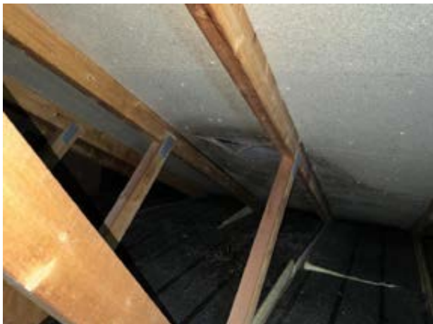
Takkonstruksjonen fremsto som tørr på befaringsdagen, også ved det tidligere reparerte området.
