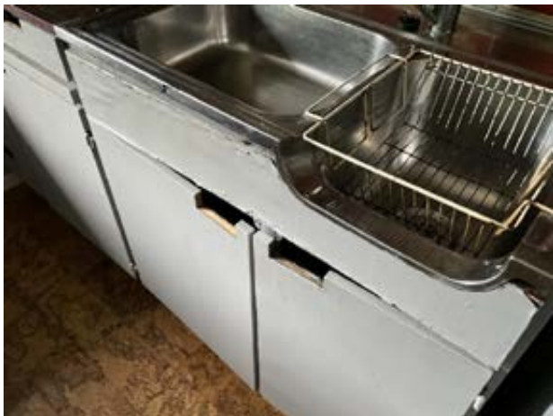
Detaljbilder som viser tilstanden på bygningsdelen.
