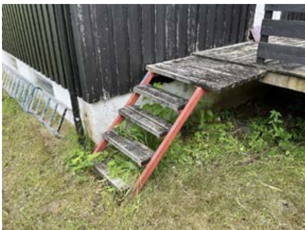
Trapp fra terrassen ned til terrenget.
