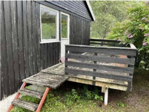
Terrasse i førsteetasje.
