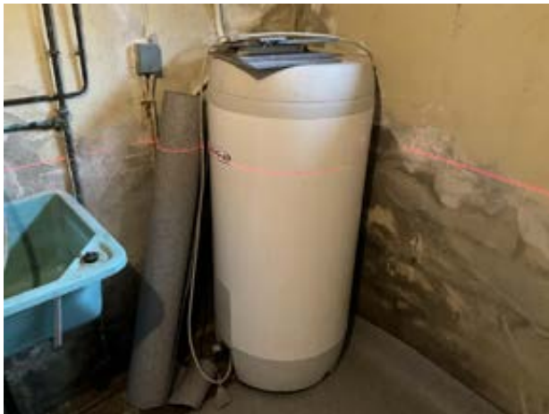
200 liters varmtvannsbereder fra 2009.
