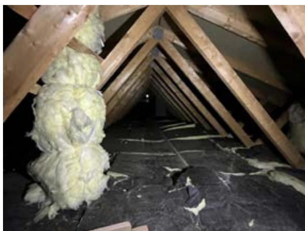
Takkonstruksjonen på kaldloftet.
