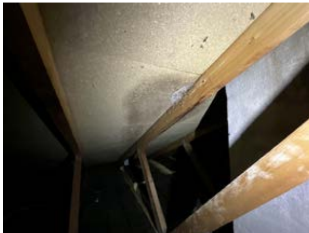
Takkonstruksjonen fremsto som tørr ved skorsteinen på befaringstidspunktet.
