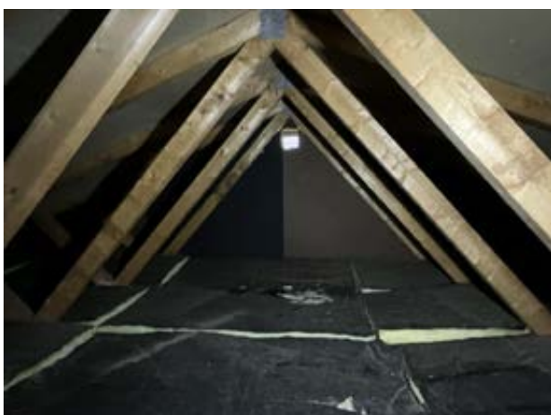
Takkonstruksjonen på kaldloftet.
