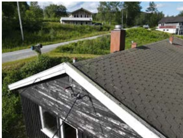
Raftveggen og vindskiene.
