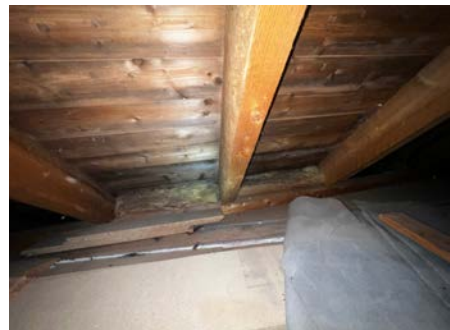
Sperrerom er fullisolert stedvis.
