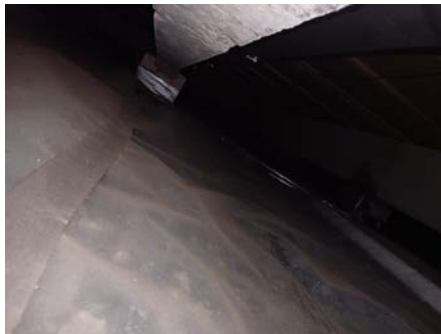
Bilde fra krypkjeller
