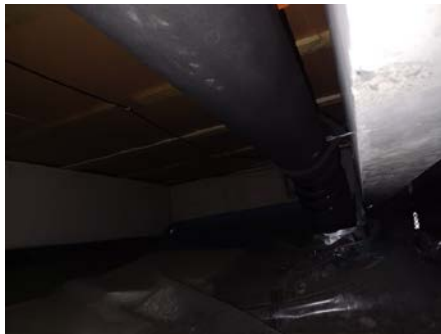
Bilde fra krypkjeller
