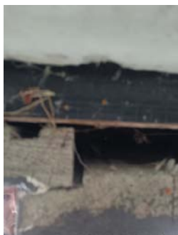
Bilde av luftspalte bak kledning
