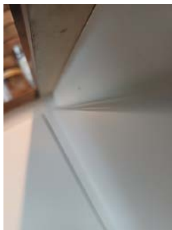
Bilde av svelling på benkeplate
