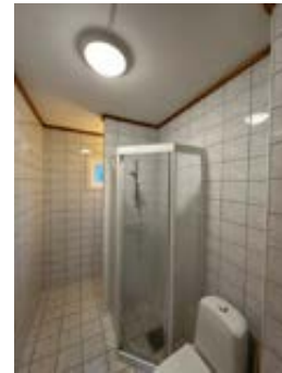
ETASJE 1 - LEILIGHET 1V > BAD
