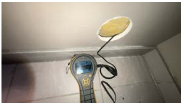
Fuktmåling mot bad.
