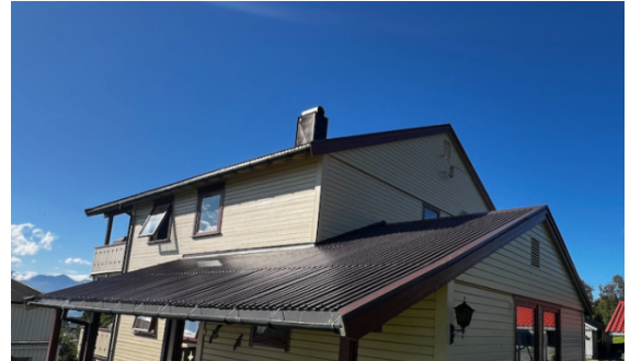
Overrisiktbilde av taktekking.
