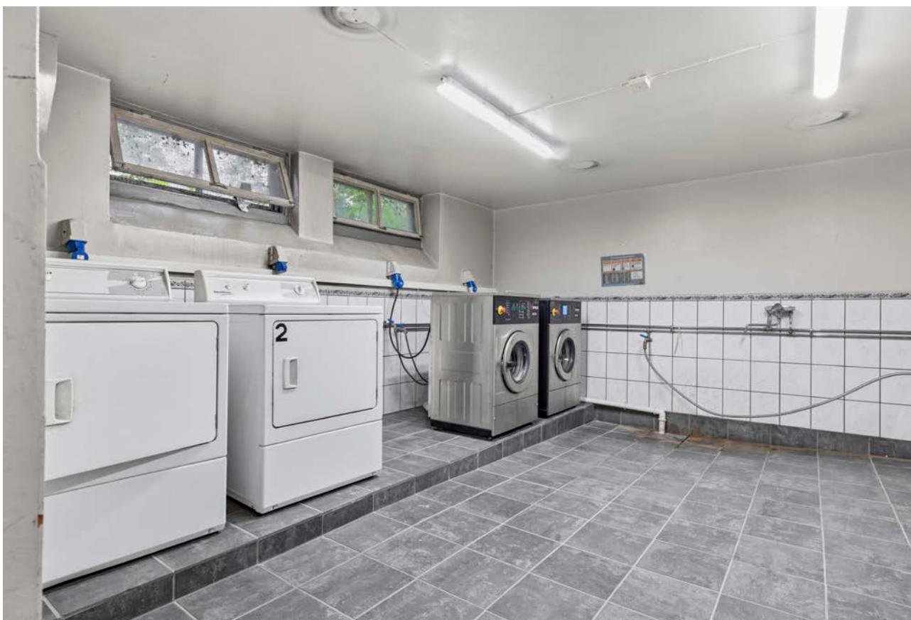
Fellesvaskeri i kjeller, samt disponerer leiligheten en netting kjellerbod på ca. 3 kvm.
