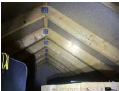
Takkonstruksjon med preste sperr.
