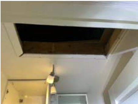
Kaldt loft er besiktigelse gjennom luke i tak med gardintrapp.
