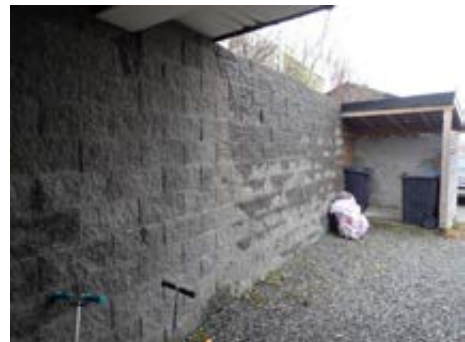
Forstøtningsmur mot terreng ved hovedinngang
