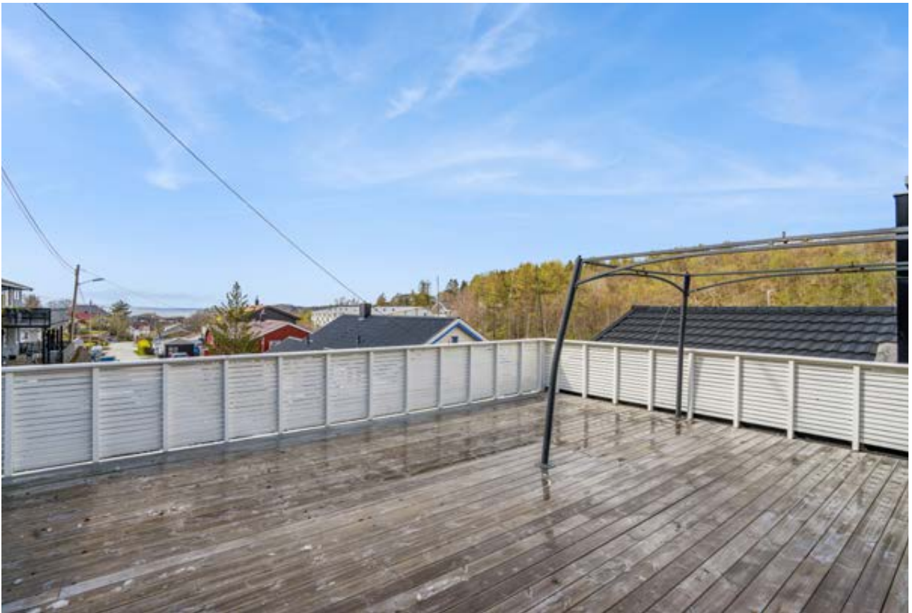
Utgang fra loftsstuen til terrassen som er oppført over inngangspartiet
