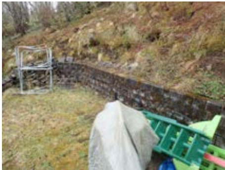
Forstøtningsmur mot terreng på baksiden
