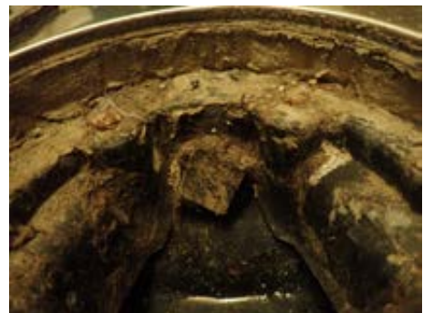
Ingen synlig membran.
