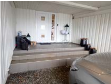
Overbygget betongtrapp foran hovedinngang.
