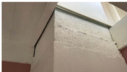
Gjennomsiktig mellom etasjene, dels upussa pipe
