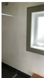
Vindu i våtsone, kledningsbord som listverk
