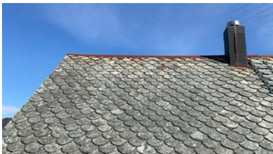
Rust mønebeslag, metallbånd over pipekledning
