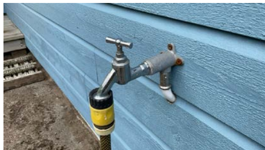
Utekran uten selvdrenerende løsning, ikke fagmessig utført arbeid.
