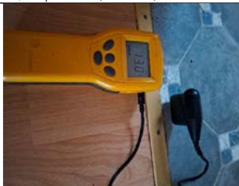
13% i kjøkkengulv under belegget
