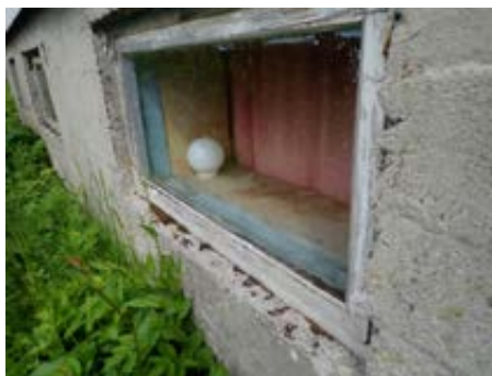
Kjellervindu- råteskadet
