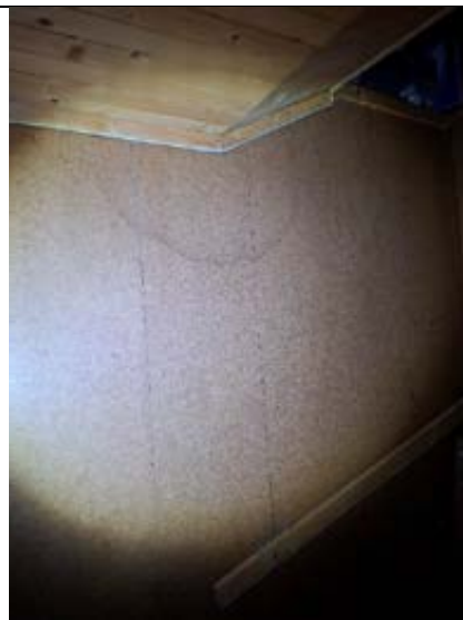
Fuktskjolder i huntonittplate. Kjeller
