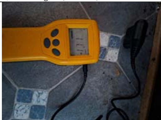
11% i kjøkkengulv under belegget
