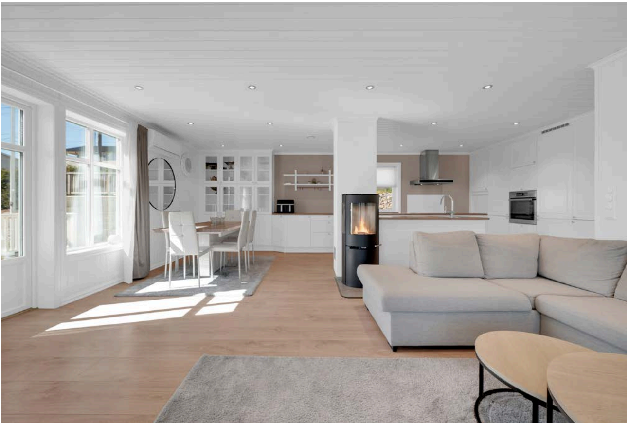
Det er montert både peisovn og varmepumpe.
