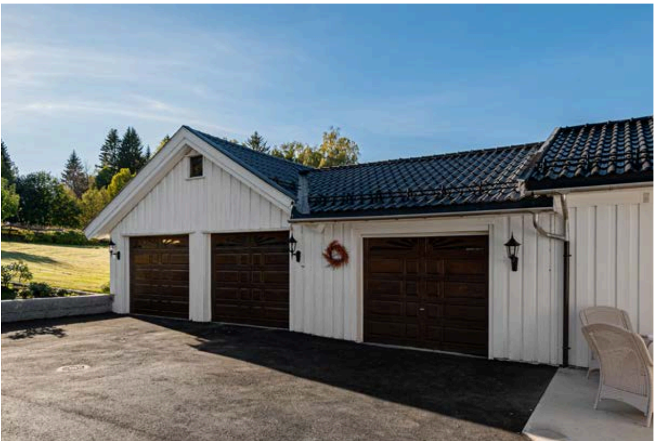
Stor garasje med tre biloppstillingsplasser og praktiske boder.
