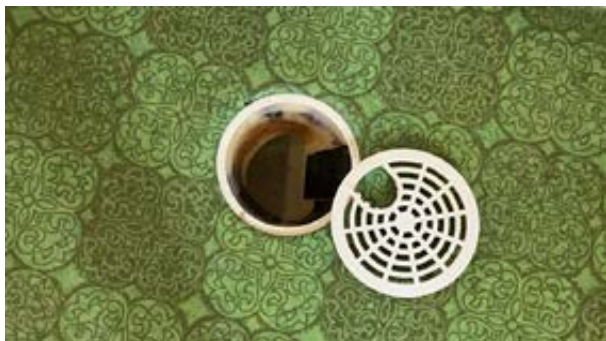
Sluk på bad
