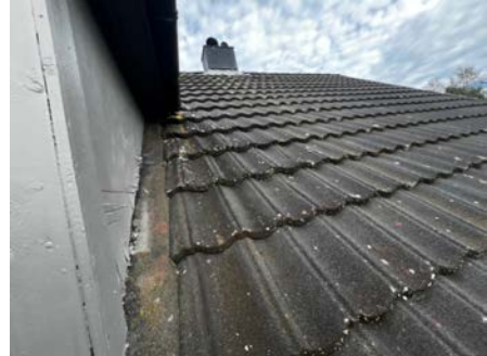
Oversiktsbilde fra luftveranda i loftet.
