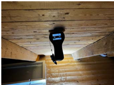
Fuktmåling i undertak, normale verdier, ikke forhøyet fuktverdier målt.
