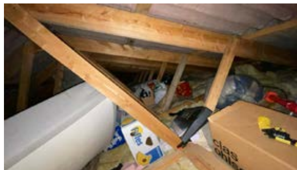
Plassbygde w-takstoler med kaldloftskonstruksjon.
