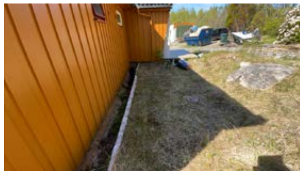
Grunnfjellet skråner ned mot boligen på nordsiden.
