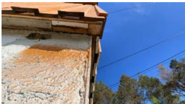
Sydvegg fremstår som etterisolert.
