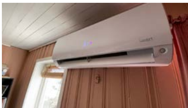
Luft til luft varmepumpe.
