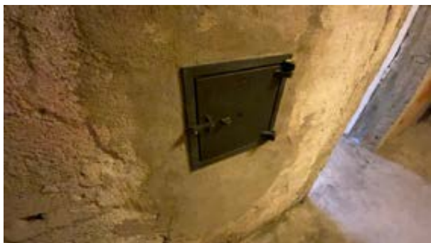
Sotluke i felles kjellergang
