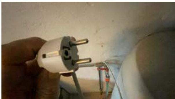
Ingen svimerker på stikk ved dagens befaring.
