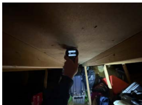
Fuktmåling i undertak, ikke utslag på fukt.
