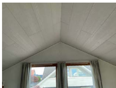
Del av takkonstruksjon er igjen-kledd.
