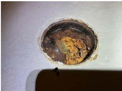
Sluk i bod med støpejern.
